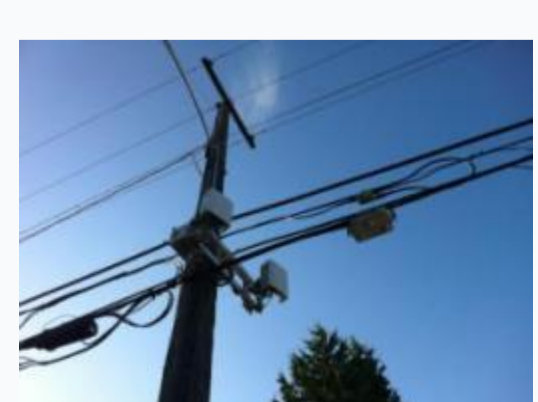
供电：通信电力杆&灯杆单独引电，独立电表管理 传输：架空光缆引入
