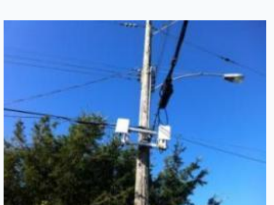
供电：通信电力杆&灯杆单独引电，独立电表管理 传输：架空光缆引入
