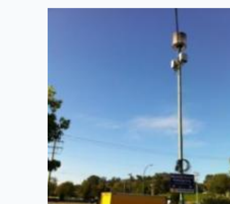
利用旧Crescent Beach片区电线杆和灯杆部署Micro，作为主流方案解决郊区弱覆盖问题
